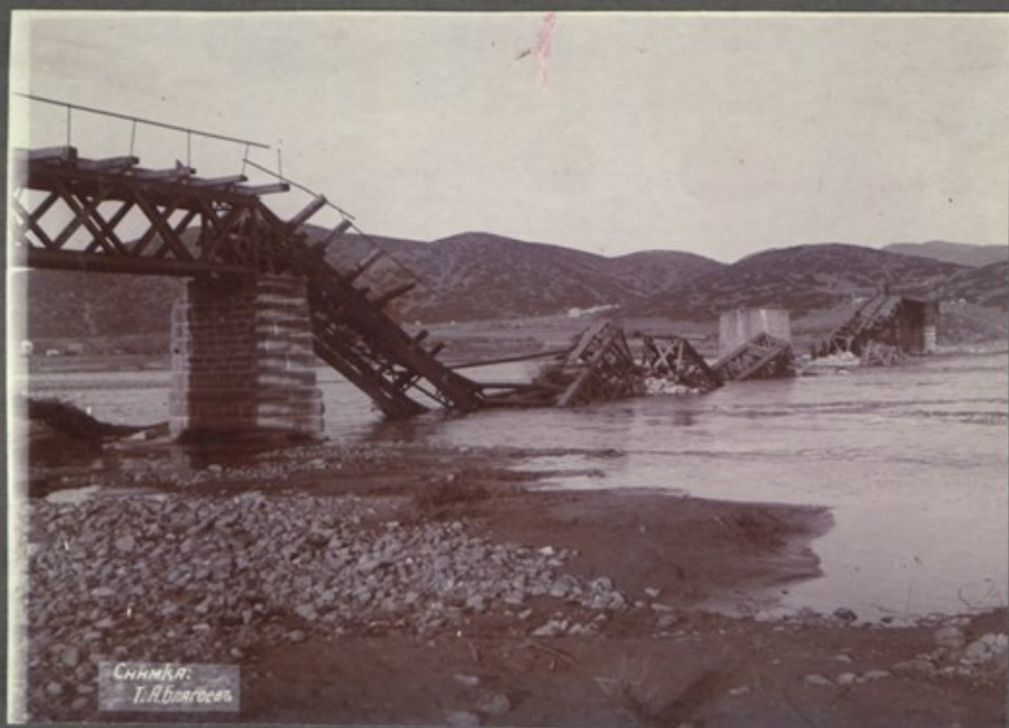
Разрушенная от англофранцузской системы на р. Вардара при г.ра Чгубо
