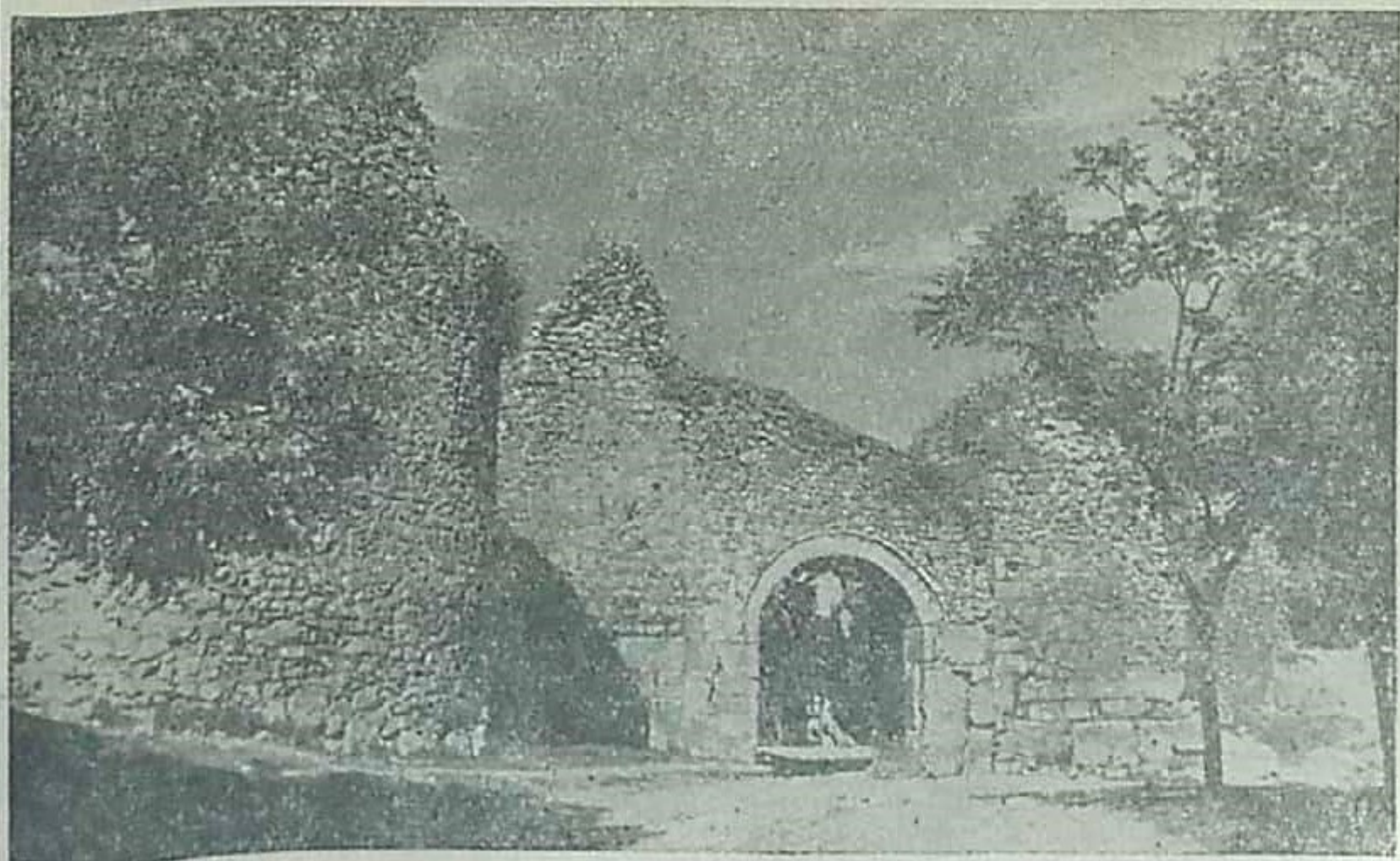
Северо-източната входна врата на Охридъ
